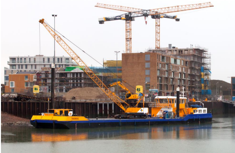
Figuur 2: Plaatsen van de damwandconstructie
